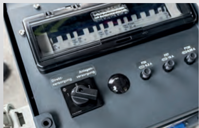
Umschalter Direktversorgung-Anlagenversorgung.
